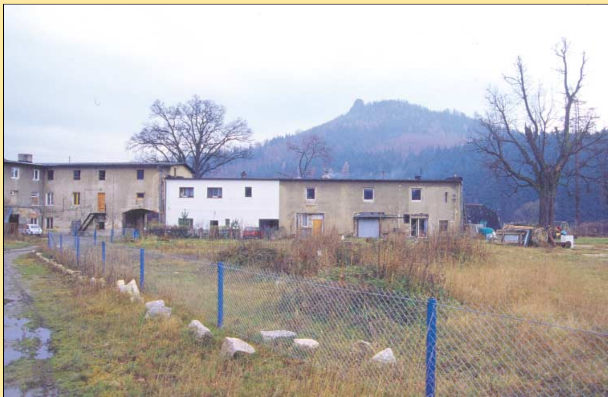
Rohrlach. Hof nach dem Abriss des Schlosses 1980, Foto: Paweł Lipiński, 2001
